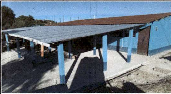
Foto 1: Finalización de sustitución de lámina, por lámina troquelada zinc calibre 26
