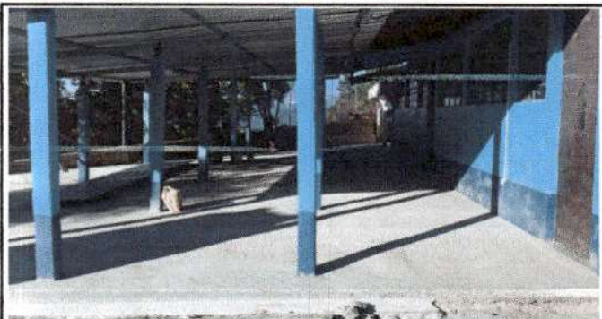
Foto 3: Finalización de reparación de piso de torta de concreto.
