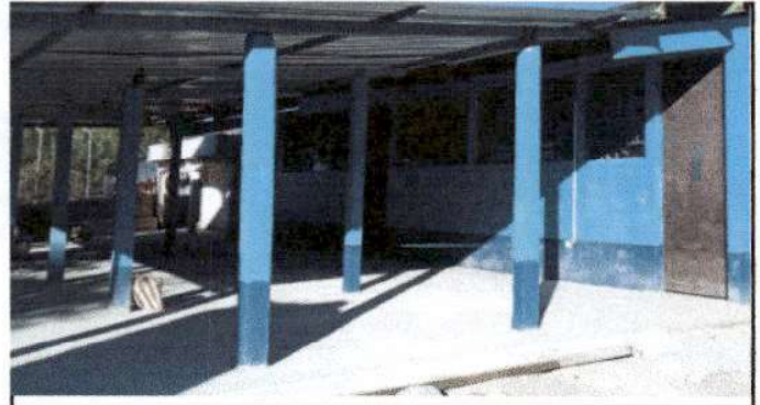
Foto 2: Finalización de sustitución de estructura de soporte de madera, por metal.
