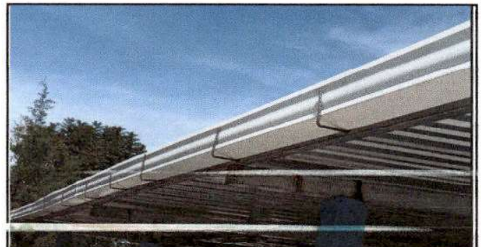
Foto 4: Finalización de sustitución de canal de pvc.
