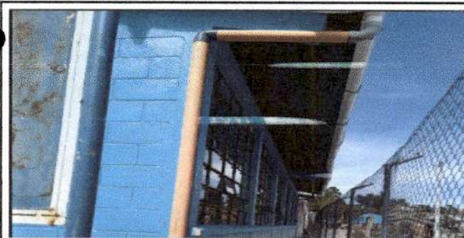
Foto 5: Finalización de sustitución de canal de pvc, sustitución de bajada de agua pluvial
